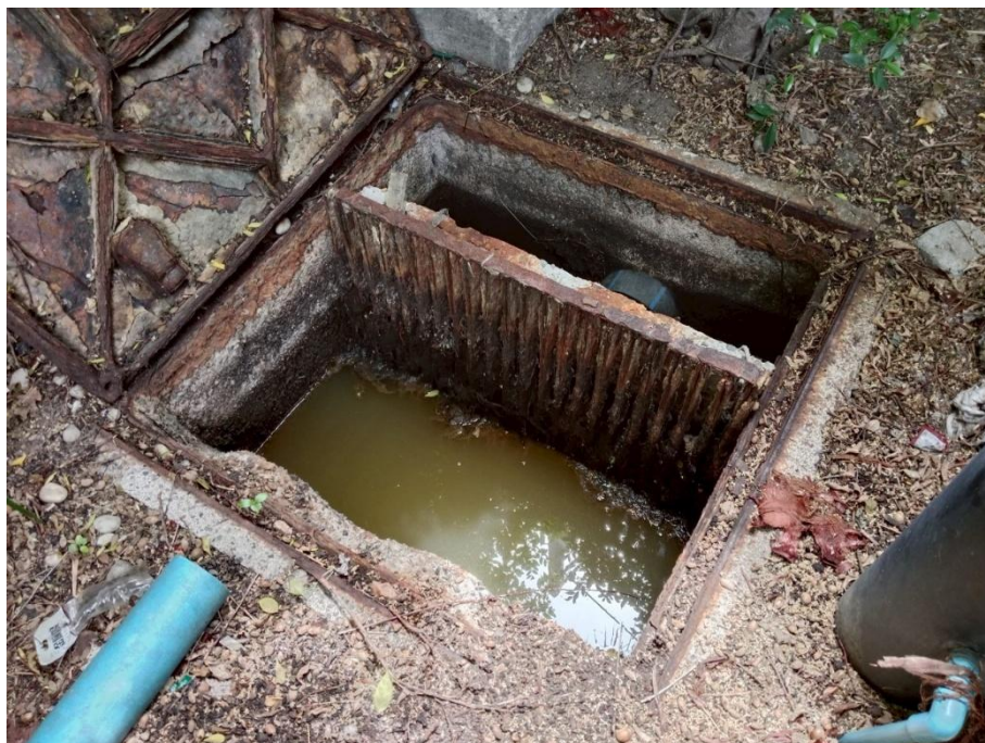
ภาพที่ 21 แสดงบ่อบำบัดน้ำเสียที่ติดตั้งตะแกรงคัดมูลฝอย
