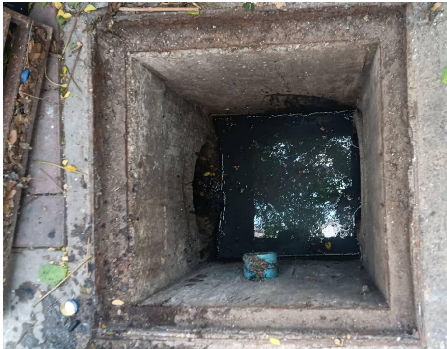
ภาพที่ 40 ทำความสะอาดขุดลอก Manhole บ่อหน่วงน้ำและท่อระบายน้ำ ของโครงการ
