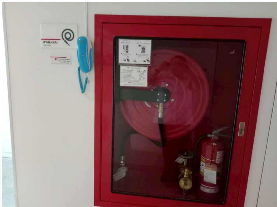
ภาพที่ 6 แสดงถังดับเพลิง และป้ายแสดงจุดติดตั้ง
