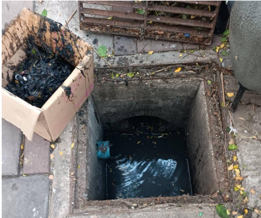
ภาพที่ 39 ทำความสะอาดขุดลอก Manhole บ่อหน่วงน้ำและท่อระบายน้ำ ของโครงการ
