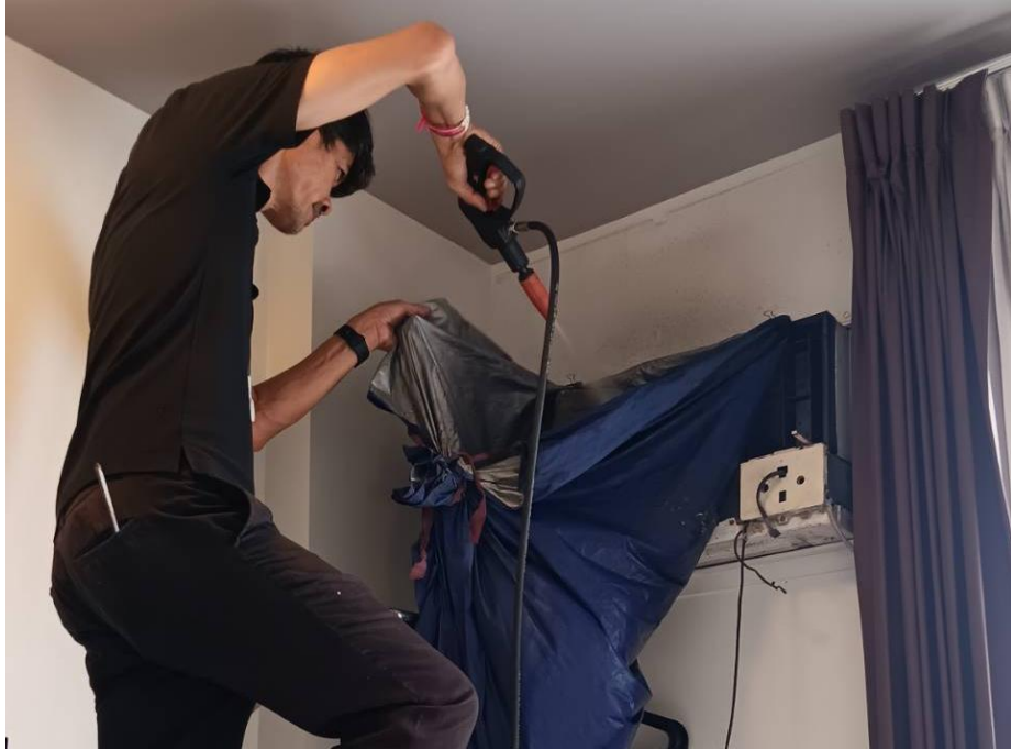
ภาพที่ 31 เจ้าหน้าที่ทำการล้างเครื่องปรับอากาศภายในโครงการ
