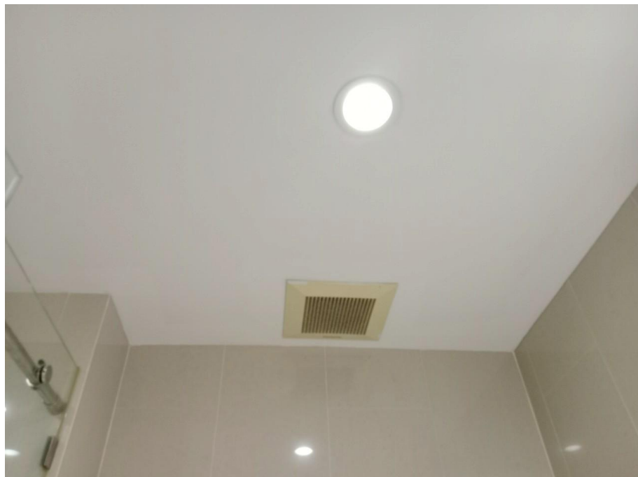
ภาพที่ 10 แสดงระบบระบายอากาศ ภายในห้องน้ำของโครงการ
